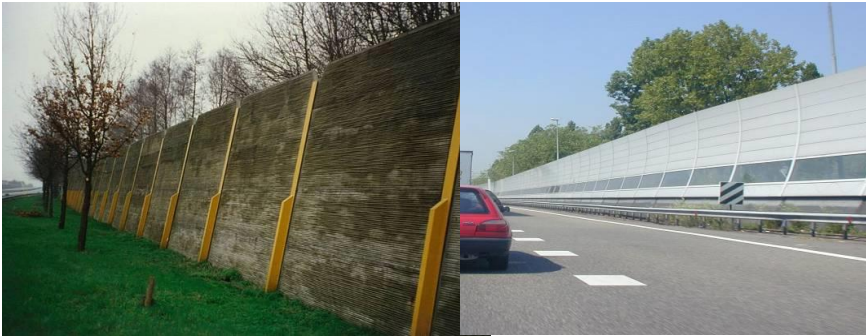
Figuur 9: Geluidscherm van primair materiaal Hout met constructiemateriaal Metaal (links) en geluidscherm van primair materiaal Metaal met secundair materiaal Glas/Kunststof Transparant (rechts).
